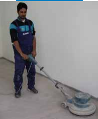
Lijado previo a la aplicación de Ultraplan Eco - Asilo Mirabello de Cantù - Italia
