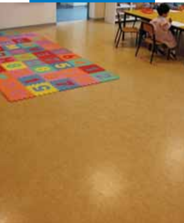
Linóleoum aplicado sobre recrecido nivelado con Ultraplan Eco - Asilo Mirabello de Cantù - Italia
