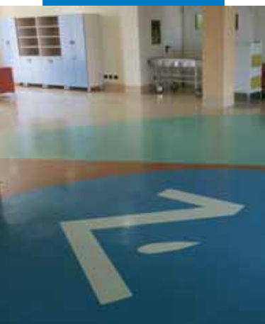
Ejemplo de colocación de PVC en ambientes de larga hospitalización - Casa de Reposo San Martino - Italia
