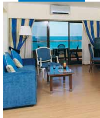
Colocación de PVC en una suite de hotel - Iber Hotel - Portugal
