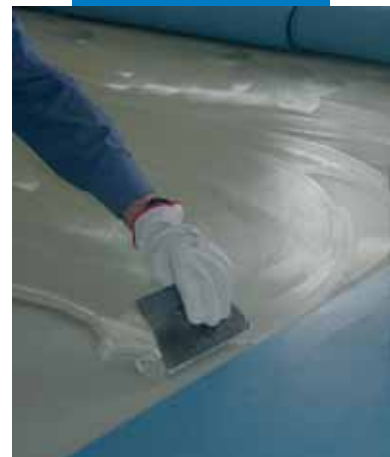
Aplicación de Ultrabond Eco V4 SP - Casa de Reposo San Martino - Italia
